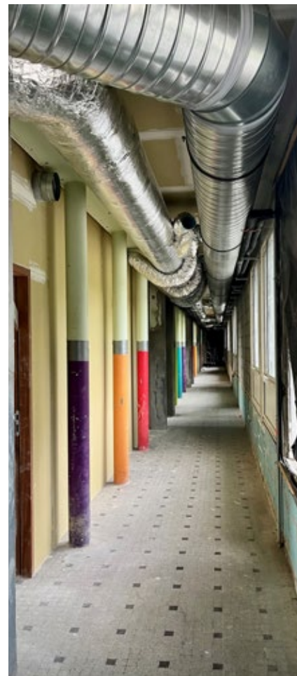
Les travaux continuent dans le collège de Laragne-Montéglin.
